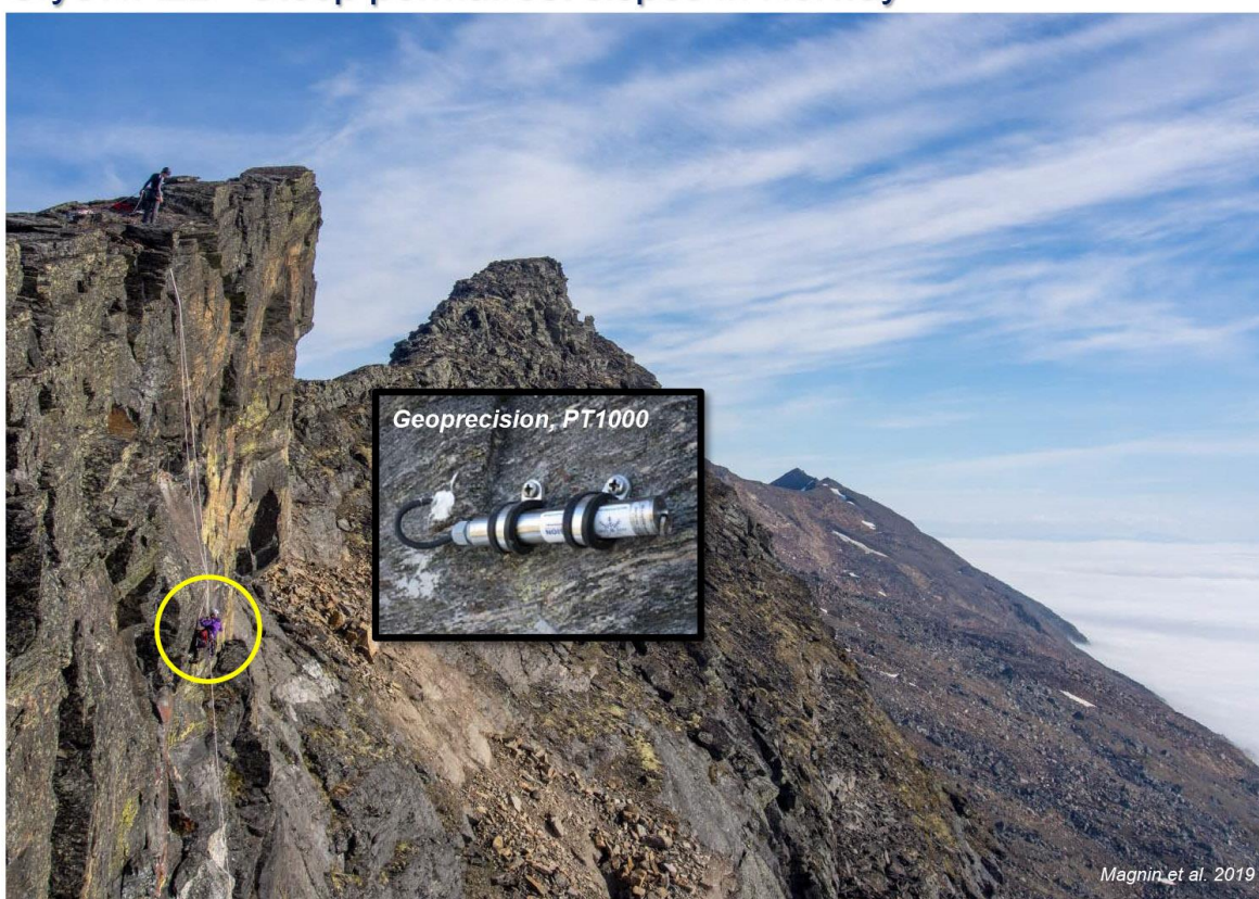
Figur 12: Installasjon av temperaturobservasjoner 5-10 cm inn i fjellvegger i områder med ustabile fjellparti i det norske høyfjellet.
